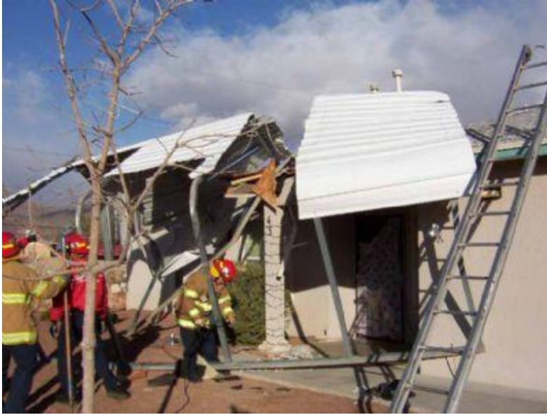
Damage carport in El Paso. El Paso Fire Department for the El Paso Times
