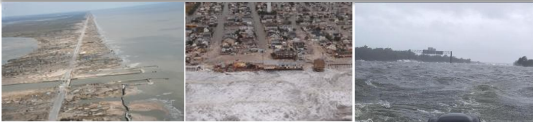
Izquierda: Península de Bolívar arrasado por las marejadas ciclónicas asociadas al Huracán Ike en el 2008. Centro: Casas dañadas y destruidas a lo largo de las costas de New Jersey tras el paso de Sandy en el 2012. Cortesía de la Guardia Costera de los Estados Unidos. Derecha: Olas en la carretera I-10 a lo largo de la línea del condado de Jefferson/Chambers en el sureste de Texas durante la tormenta tropical Harvey en 2017.
