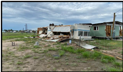
Arriba: Remolque volcado y sin anclar, destruido por ráfagas de viento estimadas en 75 mph (120 km/h) en San Carlos, Texas (al este de Edinburg), tras el paso del huracán Hanna a finales de julio de 2020.
