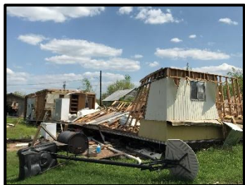
Arriba: Esta casa móvil en el Condado de Refugio, TX fue destruida por el Huracán Harvey en el 2017.
